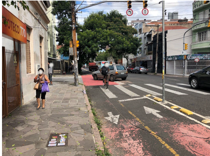
Foto 4: Ciclovía da Rua José do Patrocínio. Esquina com Rua Lopo Gonçalves. Semáforo específico para ciclistas. Fonte: o autor (2019).
