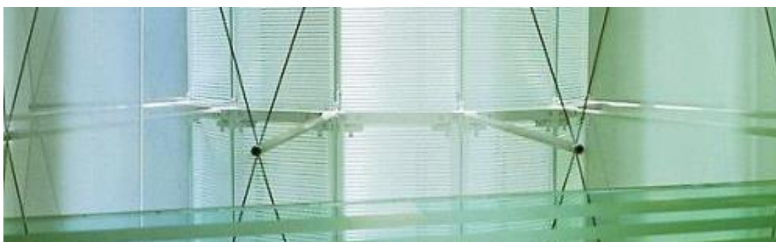
Figura 61 – Estrutura em steel frame e os painéis prismáticos do sistema.
