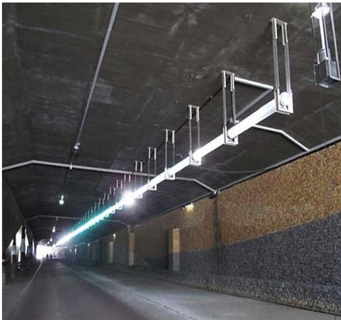
Figura 39 – Exemplo de dutos com lentes internas para transmissão da luz (à esquerda) e esquema de duto prismático oco (à direita).
