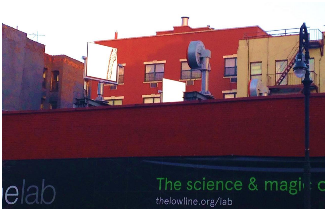
Figura 47 – Refletores e concentradores de luz solar, localizados na cobertura da edificação que abrigará o futuro parque subterrâneo.
