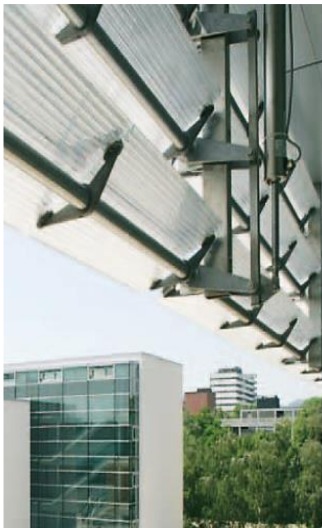
Figura 36 – Exemplos de aplicação de painéis cortados a laser em fachadas, e corte esquemático do comportamento do raio solar ao passar pelo material.
