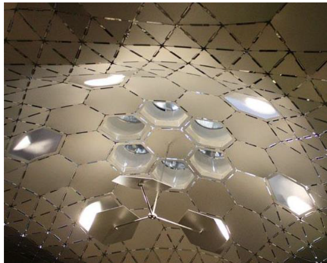
Figura 2. Sistema de reflexão da luz natural captada
