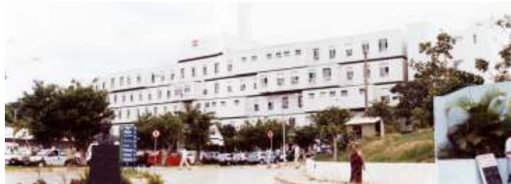
FIGURA 6.9 - Vista da fachada da Hospital Regional
