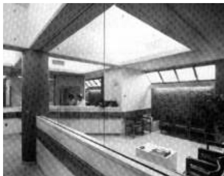
FIGURA 4.5 - Hospital Charlotte Hungerford Integração entre estrutura e sistemas de instalações. Fonte: LAM, 1977.
