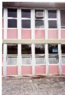
FIGURA 6.7 Aberturas das fachadas do Hospital Infantil
