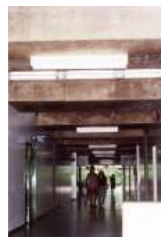
FIGURA 6.11 - Aberturas zenitais na circulação do ambulatório
