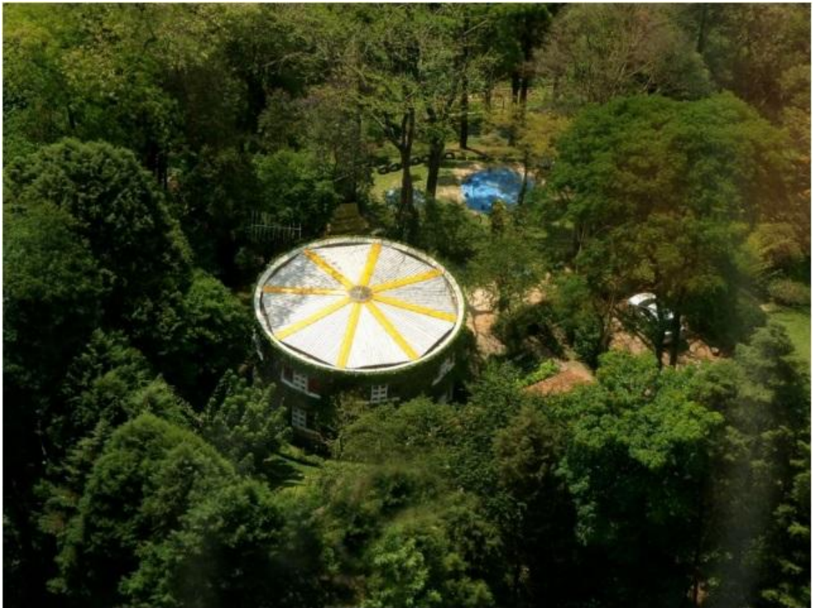
Figura 1 - A Casa Redonda vista de cima
