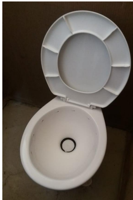
Figura 10 - Destaque para o interior do vaso sanitário de meio litro.
