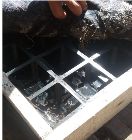
Figura 20 - Destaque para o armazenamento de água no Sistema Laminar Médio.
