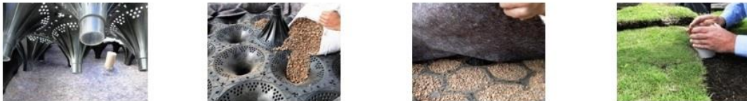
Figura 18 - Esquema de montagem do Sistema Laminar Alto.
