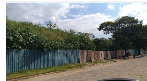
Vista da Rua Padre M. Kolbe. Presença de lixo nas ruas.
