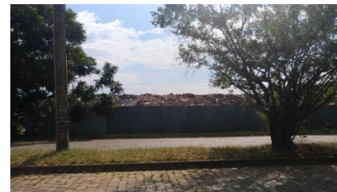
Vista da Av. Gobbi. É possível ver montanhas de entulhos no local.
