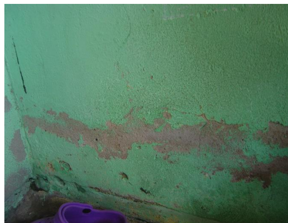
Figura 117 – Pintura descascada no Loteamento Chapéu do Sol
