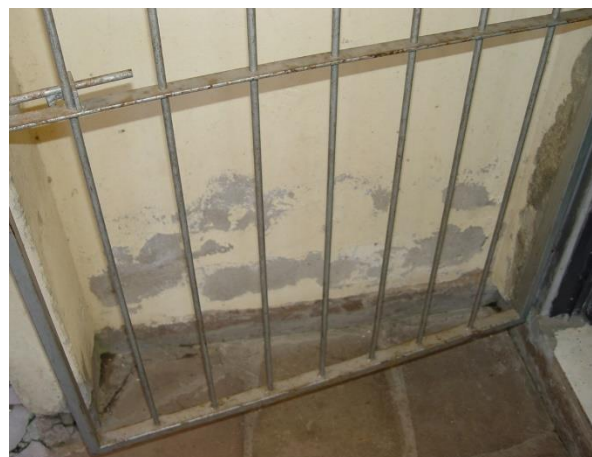
Figura 119 – Pintura descascada no Loteamento Chapéu do Sol
