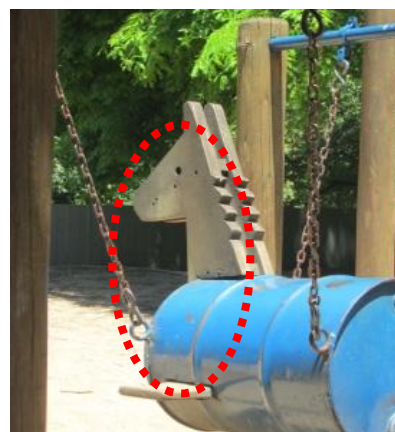
(c) Falta apoio no cavalo de tonel
