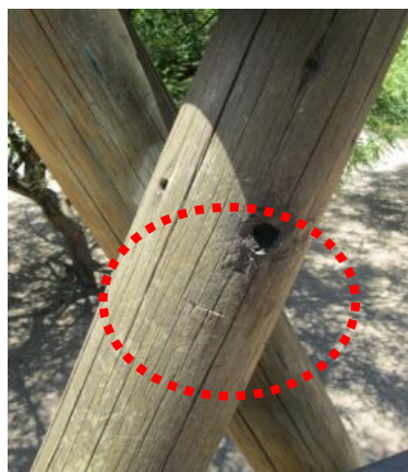
(a) Parafusos faltando nos equipamentos - tirolesa
