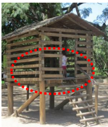
(b) Falta de partes dos equipamentos - casinha
