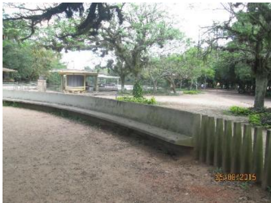
(a) Detalhe do cercamento PF1
