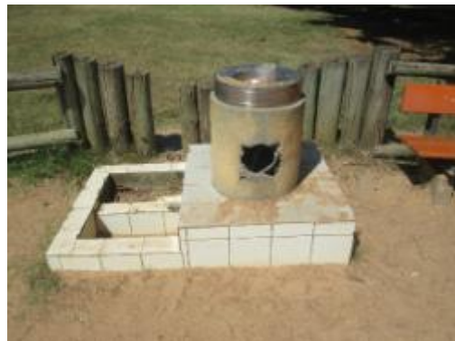
(c) Bebedouro com acionador quebrado
