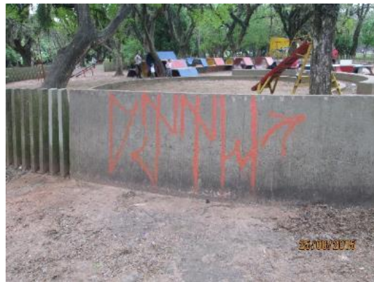
(b) Detalhe do cercamento PF3
