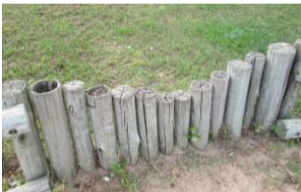
(b) Detalhe da falta de manutenção da cerca em toras de madeira
