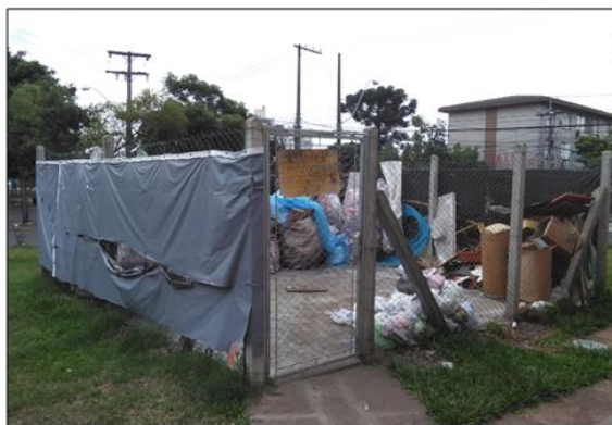
Figura 33 – Lixeiras Condominiais à intempérie
