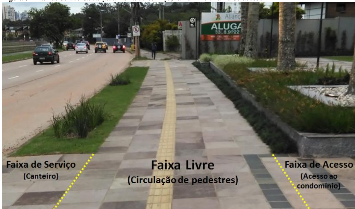
Figura 5 – Faixas de uso da calçada: faixa de serviço, faixa livre e faixa de acesso
