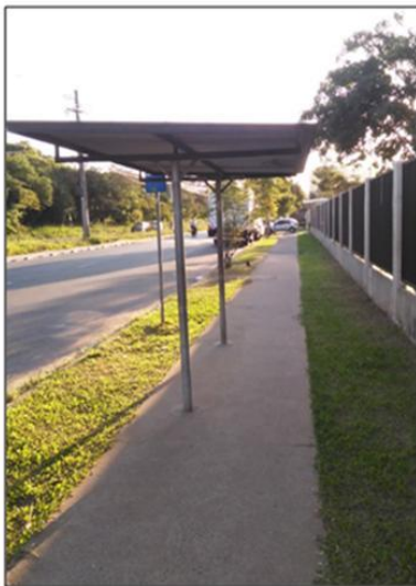
Calçada ao redor dos empreendimentos “F e J”
