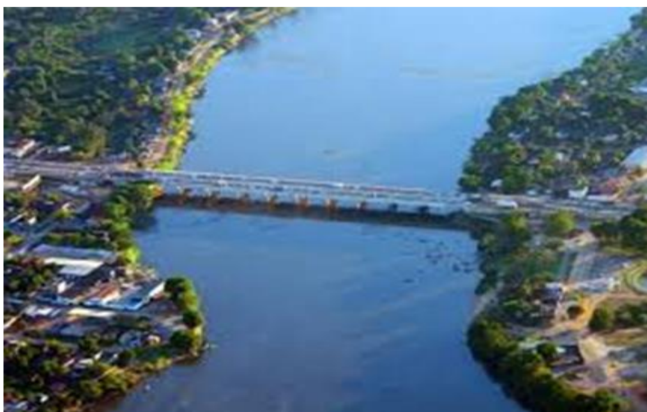
Figura 5 - Vista aérea da ponte sobre o Rio Machado em Ji-Paraná/RO.
