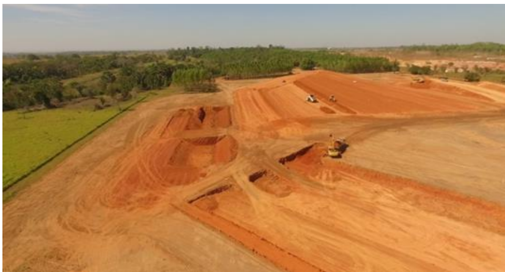
Figura 31 -Imagem aérea da construção do aterro sanitário
