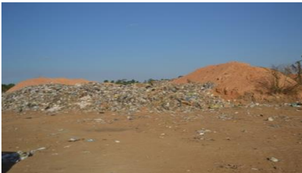
Figura 21 - Resíduos depositados em cavas, para posterior cobertura com terra, que se encontra empilhada ao lado.
