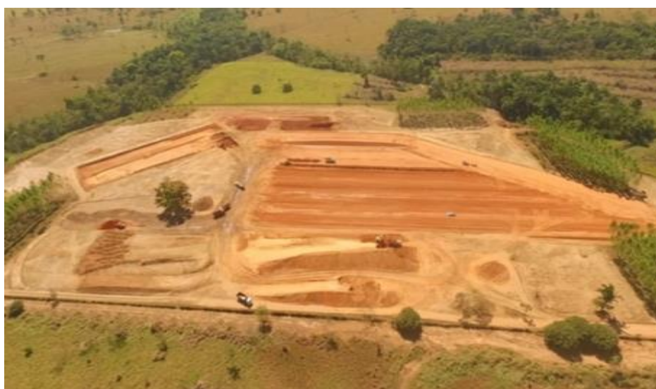
Figura 30 - Imagem aérea da construção do aterro sanitário
