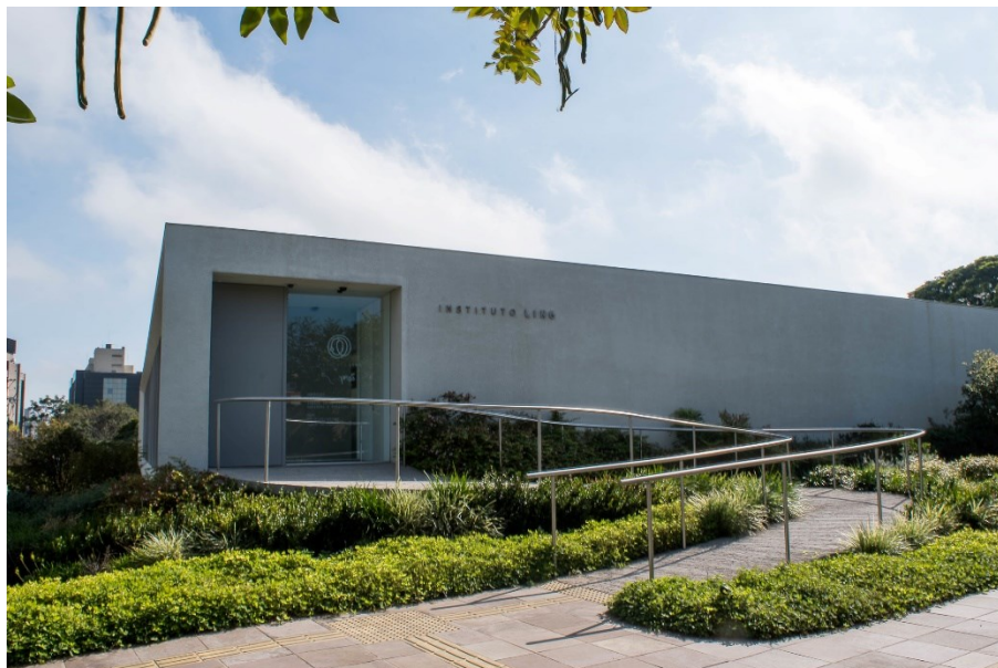
Figura 3 – Fachada do Instituto Ling
