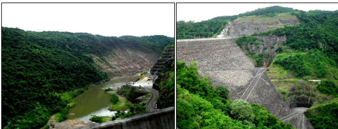
Figura 6-I- Usina Hidrelétrica de Campos Novos com face de concreto. Fotos tiradas no Trabalho de Campo – 26/11/2015
