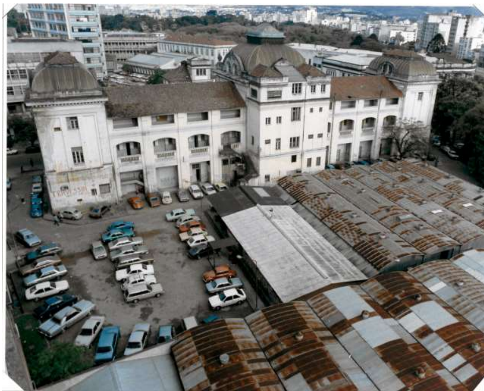
Imagem 2 - Galpões do Campus Centro, quarteirões 1 e 2, onde ficavam armazenados os acervos de Arqueologia da UFRGS antes da mudança para o Campus do Vale.
