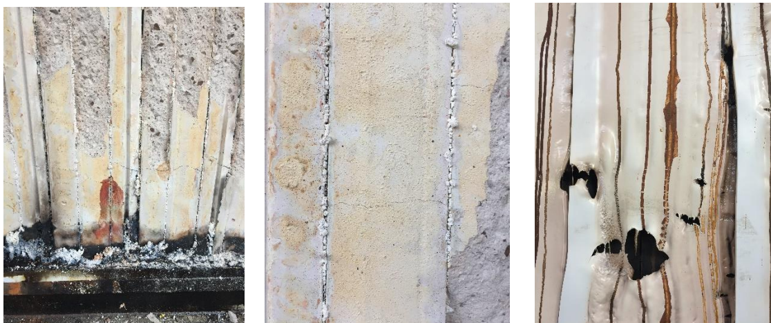
Figura 32 - Detalhes do aspecto final das superfícies dos concretos após o ensaio
