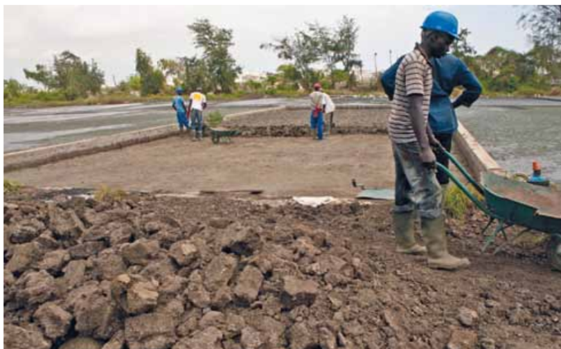
Figura 5. Remoção do lodo desaguado de leitos de secagem em Dakar, Senegal. Fonte: Strande; Ronteltap e Brdjanovic (2014).
