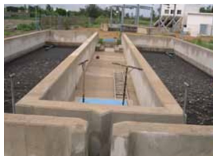
Figura 2. Adensador ( Settling/thickening tank ). Fonte: Strande, Ronteltap e Brdjanovic (2014).
