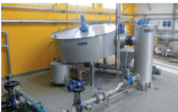
Figura 3. Adensador de lodo mecanizado. Fonte: Huber Technology [s.d.].
