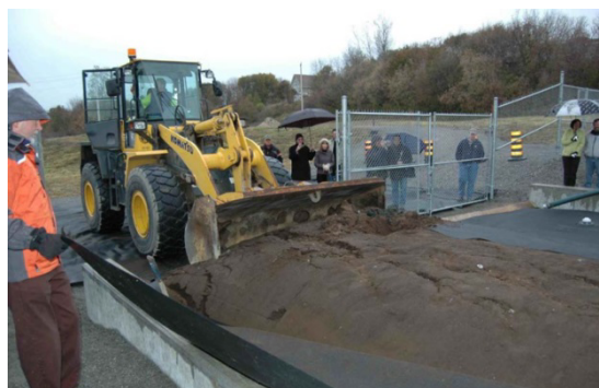
Figura 9. Bag de geotêxtil para desaguamento de lodo de tanque séptico em operação e durante a remoção do lodo desaguado após o fim do ciclo. Fonte: Drive e Polley (2010).
