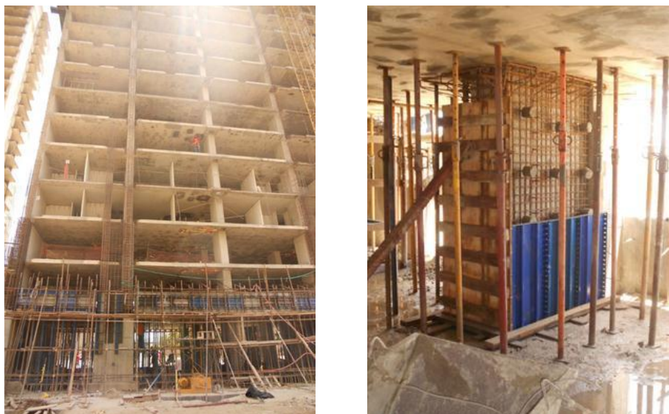
Figura 1.1: Refuerzo de columnas por medio de recrecio de su sección transversal, Torres El Sisal, Venezuela. Fuente: propia.
