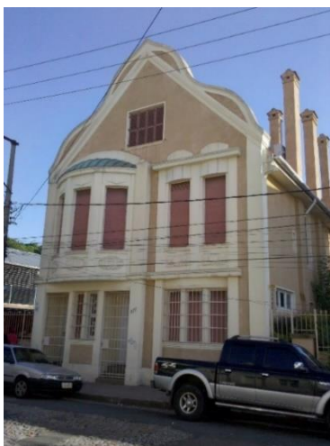
Figura 8: Prédio à Rua Comendador Coruja Fonte: Urbsnova
