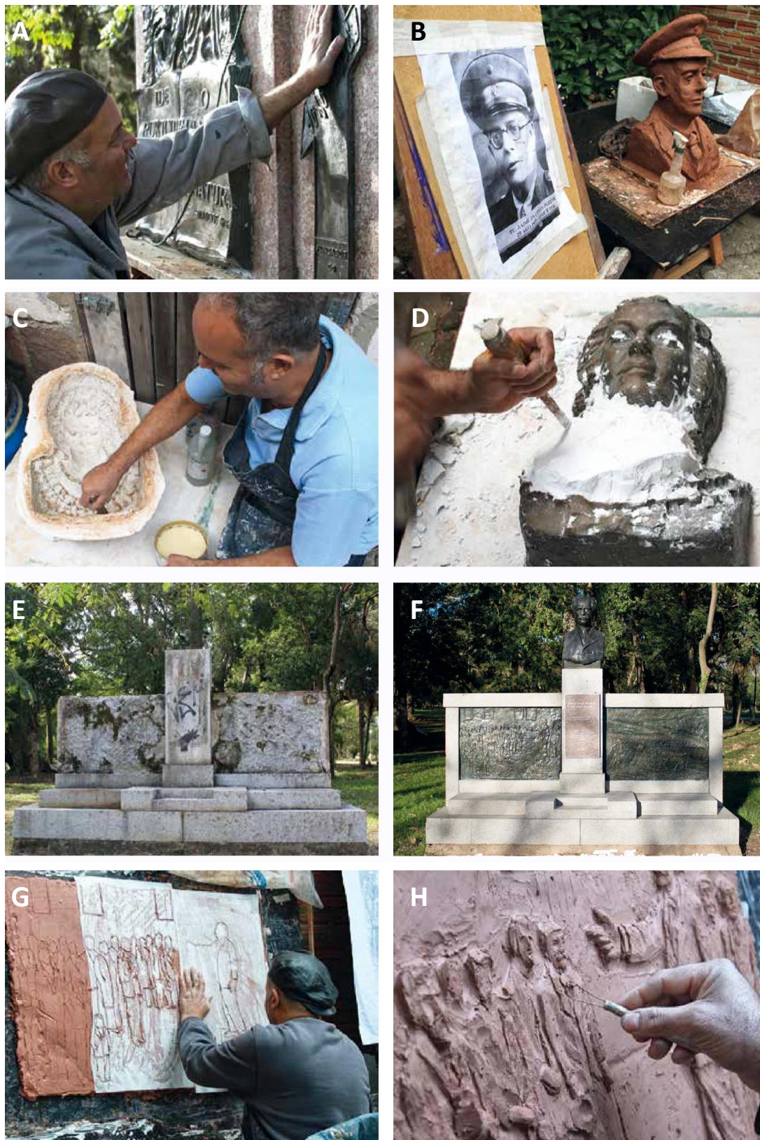
A) Escultor Luiz Henrique Mayer, B) Modelagem através de fotos, C) Construção do molde, D) Peça em resina de pó de bronze, E) Monumento antes de ser restaurado, F) Monumento a Francisco de Assis Brasil restaurado G) Remodelagem com base em fotografias, H) Remodelagem em terracota.
