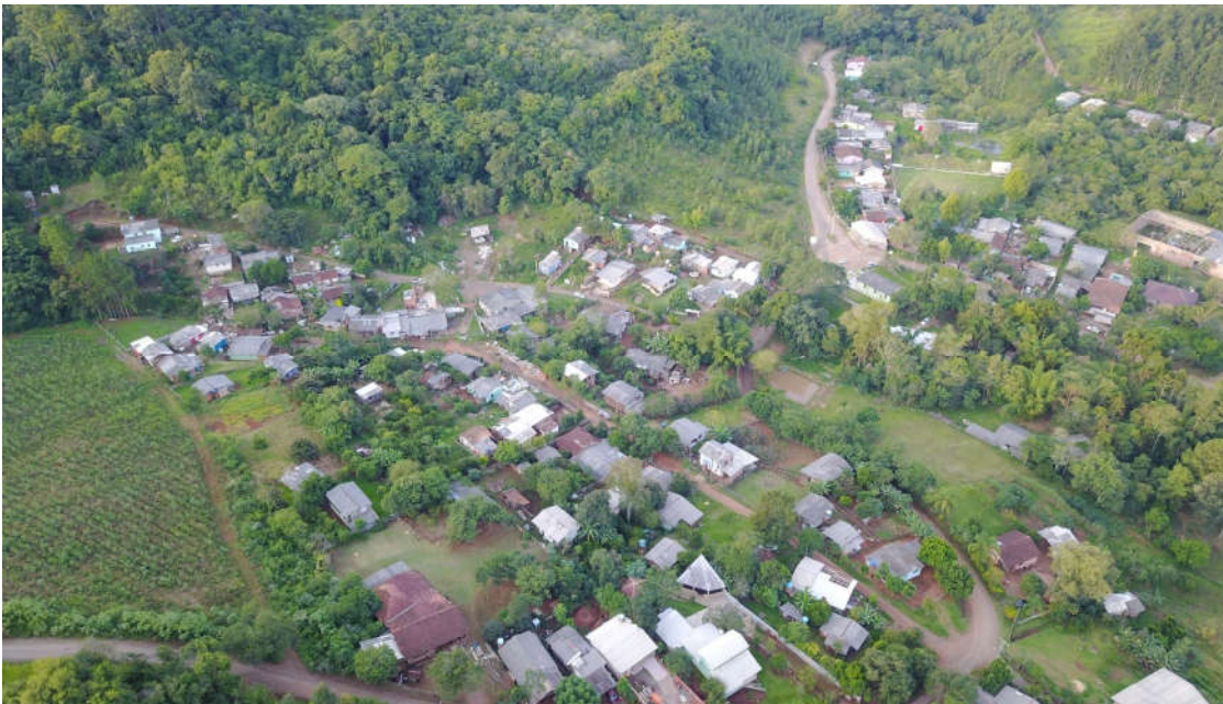
Foto 26 – Localização: vista da ocupação irregular localizada na rua Trajano Nunes Cardoso
