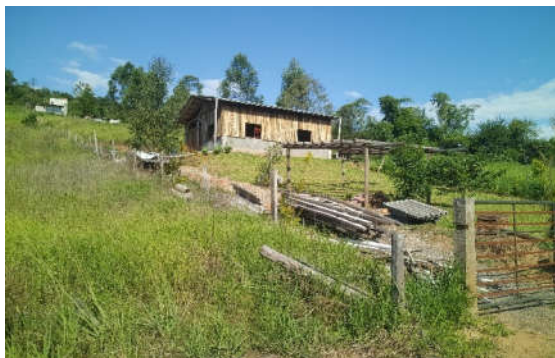
Foto 19 - Localização: estrada secundária da zona rural
