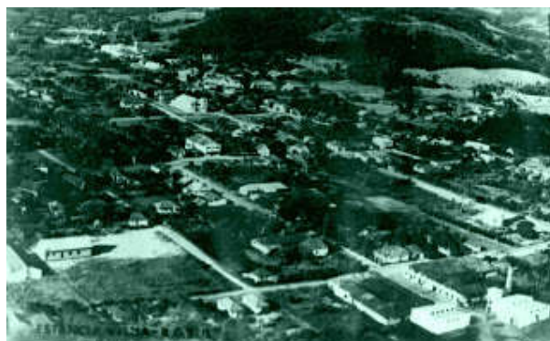
Figura 4.3: Vista da área central de Estância Velha, cerca de 1959
