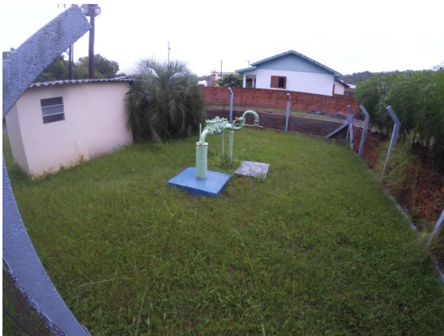
Figura 40 – Poço tubular da CORSAN.
