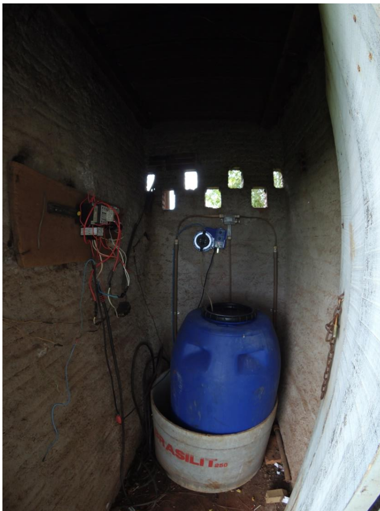
Figura 42 – Sistema de tratamento de poços, com o uso de tonel para desinfecção por cloração.
