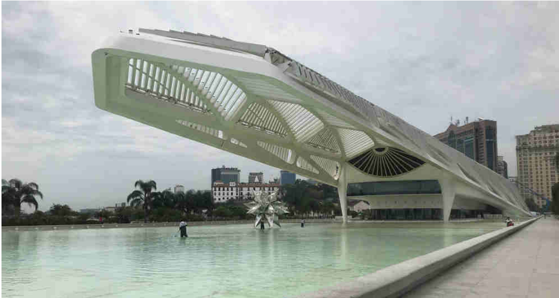
Figura 37 - Fachada posterior do Museu do Amanhã, de Santiago Calatrava (Rio de Janeiro, 2015). Fonte: autora (2018).
