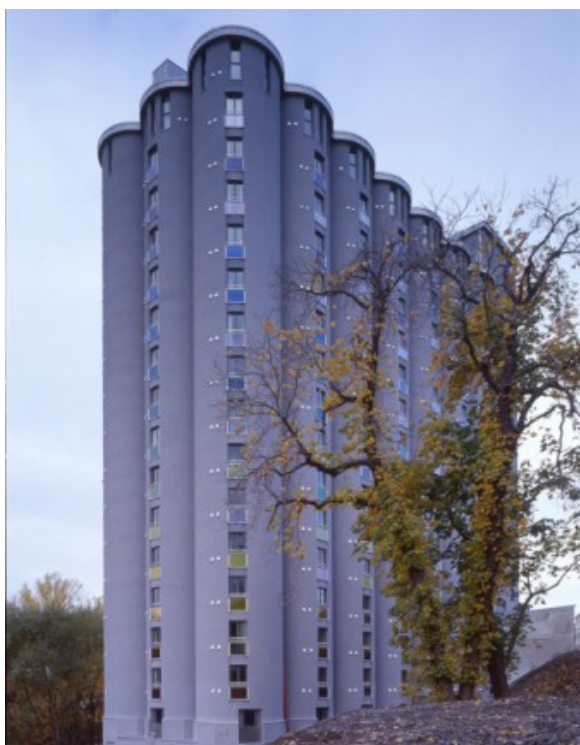
Figura 89 Grunerlokka (ao lado) - silos adaptados a residências estudantis receberam perfurações em série nas fachadas e painéis coloridos de vidro como guarda-corpos.
