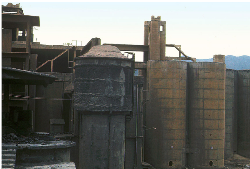
Figura 94 La Fabrica - conjunto industrial antes da reforma.
