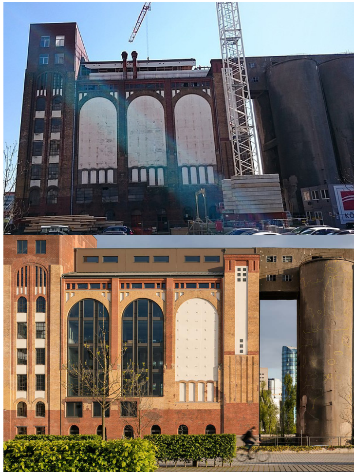
Figura 85 Plange Muhle Campus Silos - o edifício de silos alterava na fachada os tijolos vermelhos e fechamentos de gesso.
