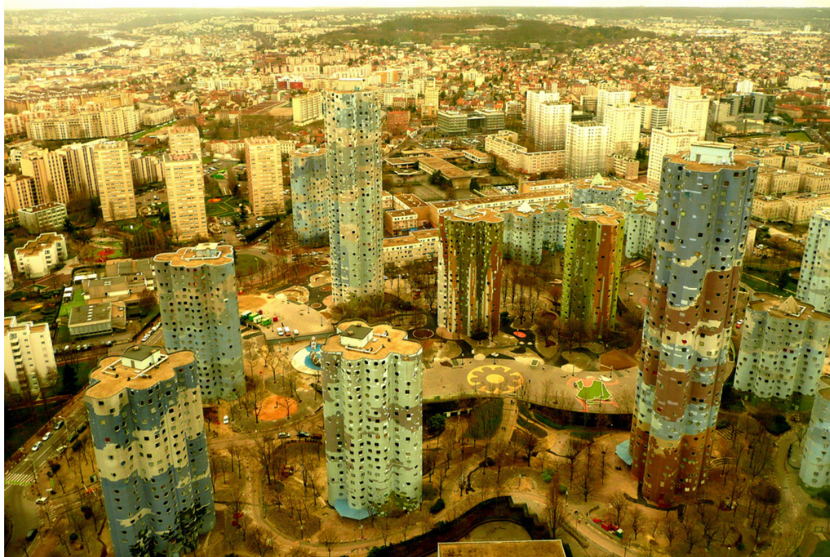
Figura 51 Tour Aillaud - Vista do conjunto de 18 torres de apartamentos com alturas variadas.
