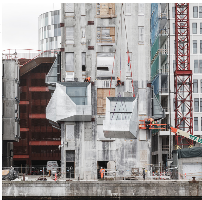
Figura 84 The Silo - detalhe da execução do revestimento por módulos e aberturas no concreto dos silos. A máscara também atua como elemento de proteção climática.
