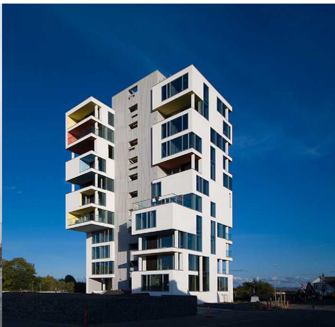
Figura 69 Siloetten - após reforma.
