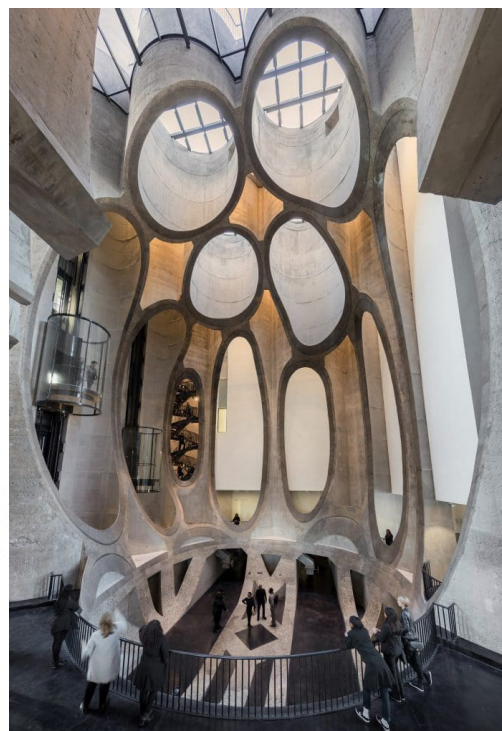
Figura 113 Zeitz MOCAA (acima) - vista interna do átrio, tubos seccionados desde o subsolo e cobertura envidraçada.
