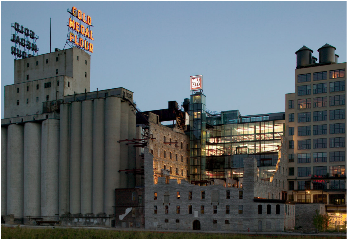
Figura 11 Mill City Museum - vista do conjunto, os silos, o moinho que foi incendiado e a nova fachada envidraçada do museu.
