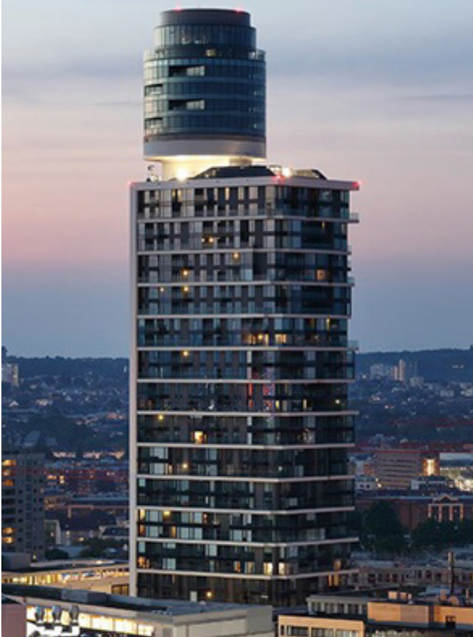
Figura 13 Henninger Turm - acima os silos que foram demolidos e eram um marco na paisagem de Frankfurt.
