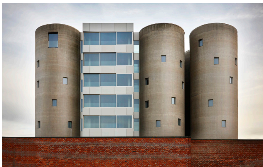
Figura 78 Kanaal (ao lado) - vista externa, substituição de duas células por volumes quadrados envidraçados.
