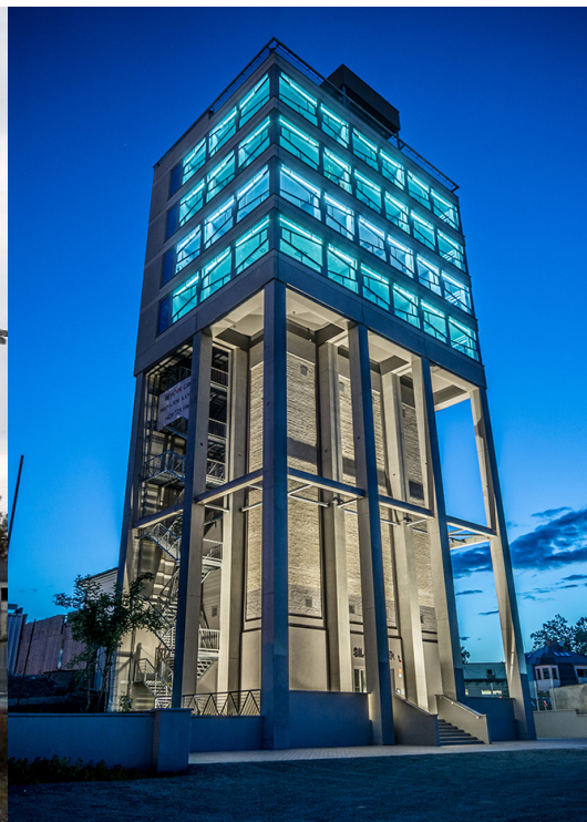
Figura 74 Silo Tower - após reforma
