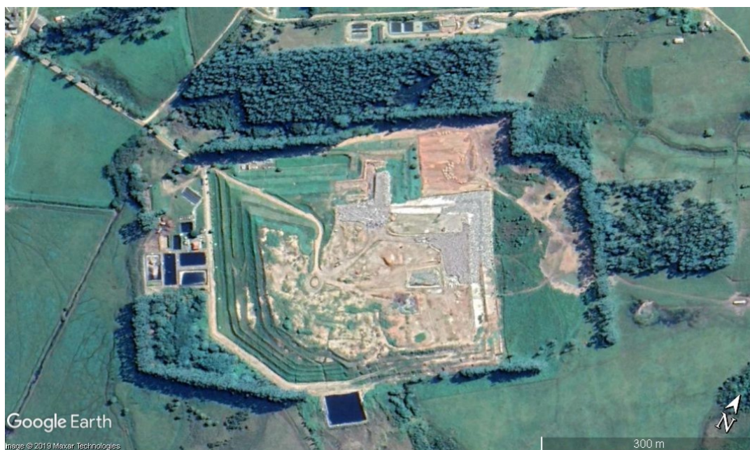
Figura 3 – Vista área do aterro sanitário de Pescaria Brava/SC.
