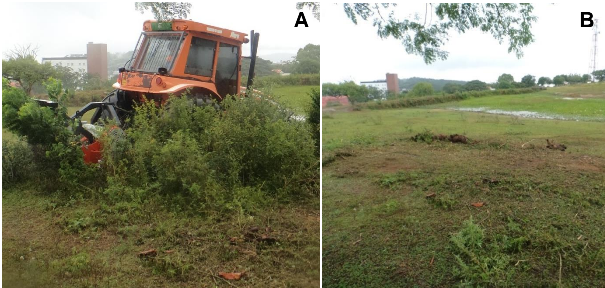
Figura 10 - Supressão da vegetação com diâmetro menor que 10 cm: (a) triturador florestal utilizado e (b) resíduo resultante.
