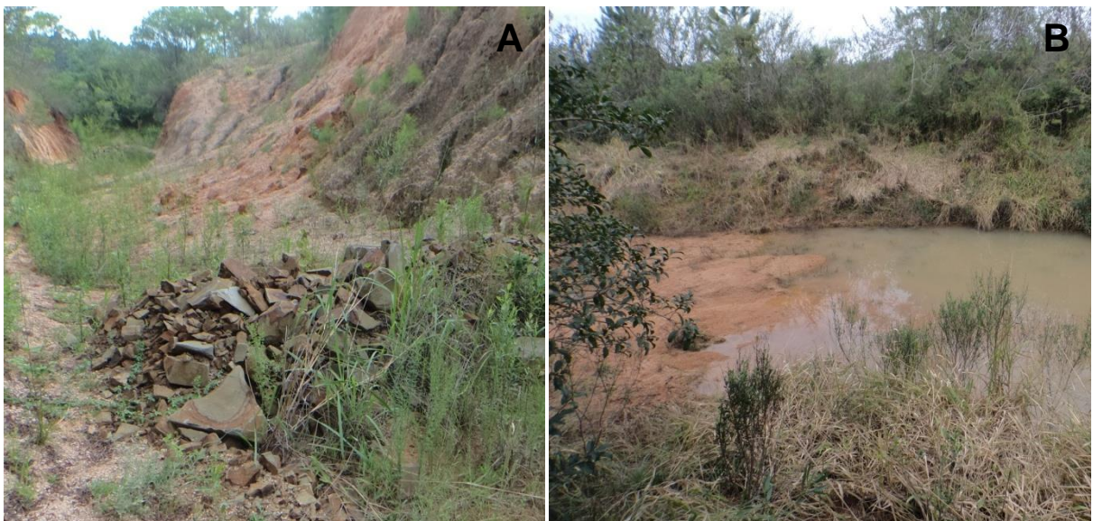
Figura 8 - Dispositivos de controle da erosão do solo e da qualidade da água que devem sofrer manutenção no empreendimento: (a) dique filtrante e (b) bacia de sedimentação.
