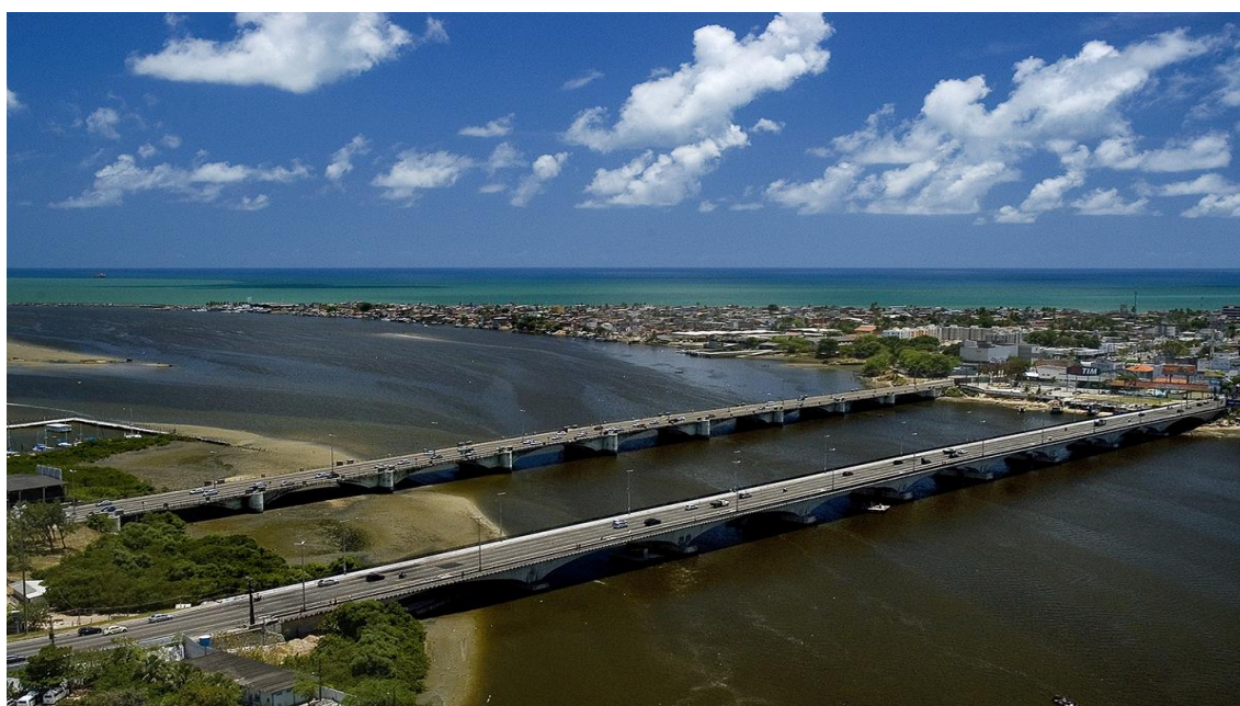
Figura 97 – Trecho da Via Mangue, em Recife
