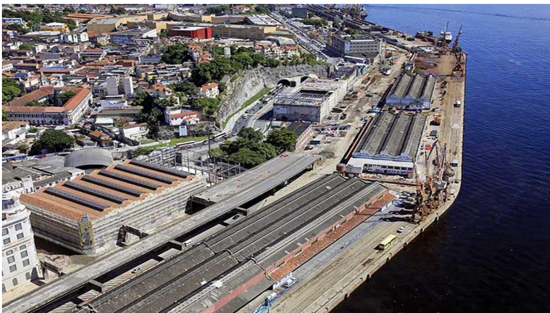
Figura 34 – Obras de demolição do Elevado da Perimetral, na Região Portuária
