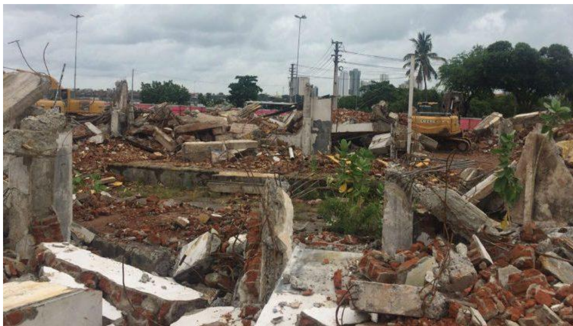
Figura 114 – Armazéns demolidos no Cais José Estelita, em março de 2019
