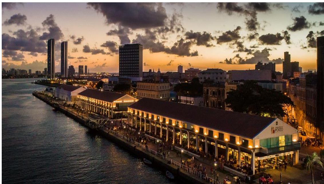
Figura 91 – Armazéns do Porto, em Recife
