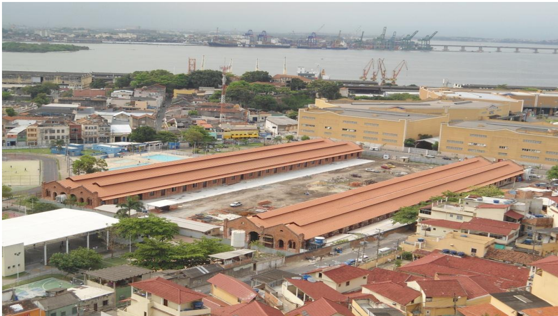
Figura 42 – Restauro dos Galpões da Gamboa
