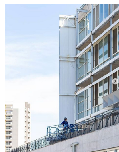
Figura 4 - Obra em conclusão
