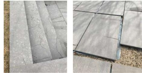
Fig. 1 – Danos estruturais e estéticos observados em amostras de dacito após período de nevasca em Nova York em 2018 (Fonte: Basalto São Cristóvão).
