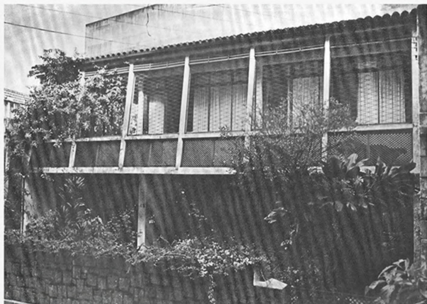
Fachada frontal original. Fonte: XAVIER, Alberto/ MIZOGUCHI, Ivan. Arquitetura Moderna em Porto Alegre
