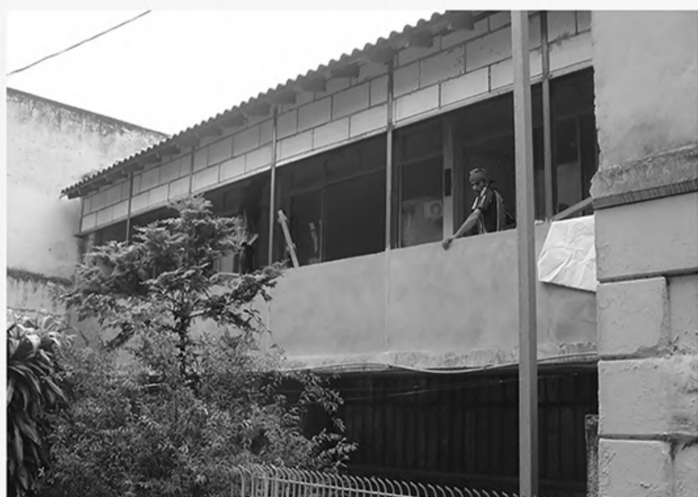
Imagem da edificação após intervenção sem responsabilidade técnica. Fotografia disponibilizada pela arquiteta Paola Maia.
