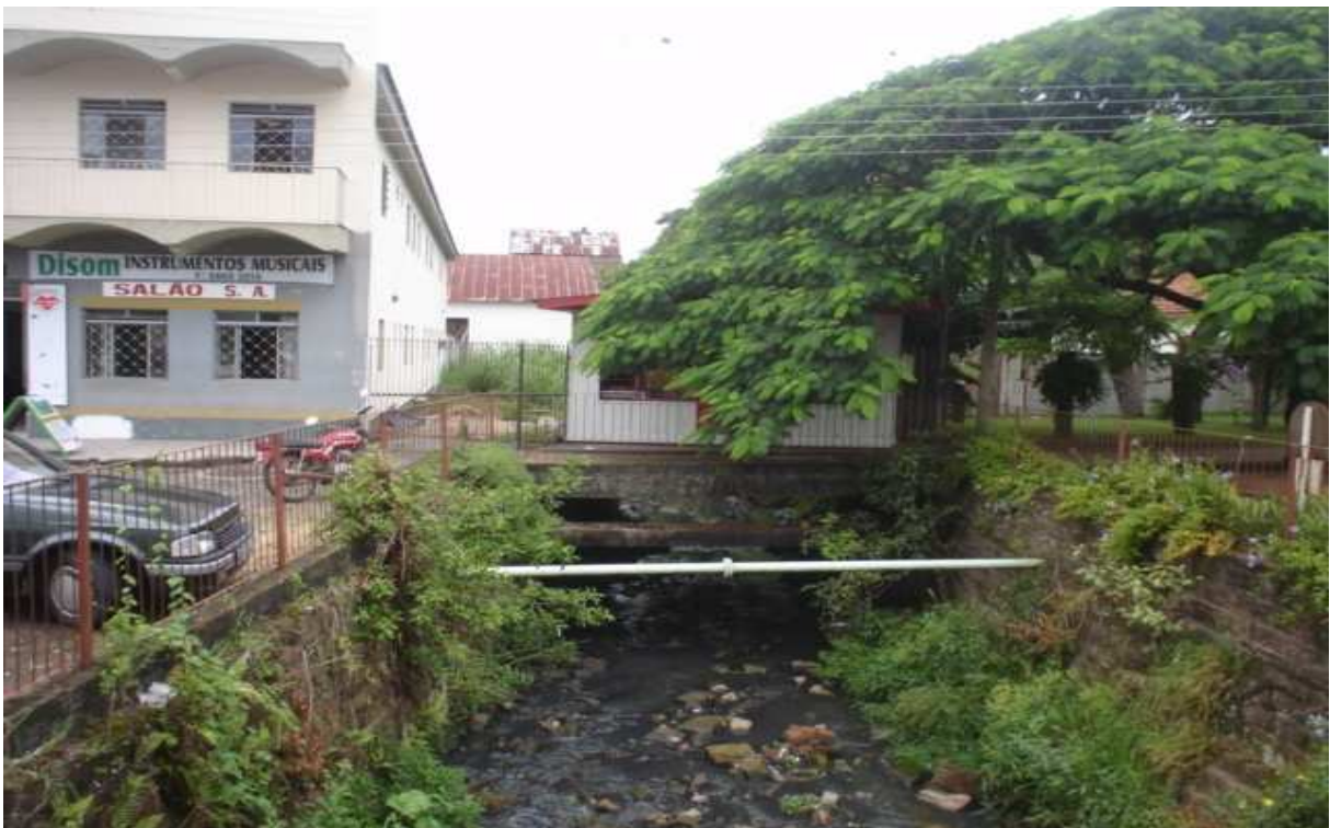
FIGURA 1.1 - Margens do arroio Pitangueiras em que se observa parte do arroio concretado e a faixa de APP ocupada por estabelecimentos comerciais e prédio residencial – centro da cidade.
