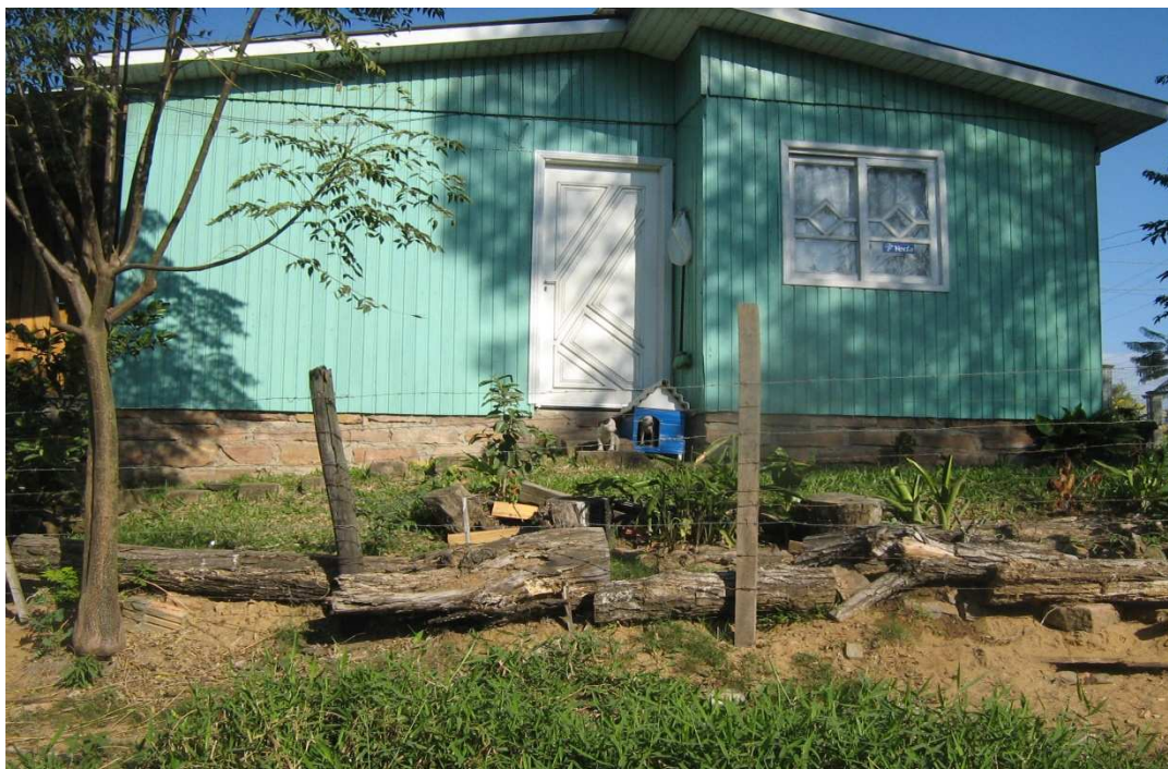
FIGURA 7.2 – Fundo da casa voltado para o arroio o que indica o padrão de habitação classificado como de média renda existente na faixa de APP do Pitangueiras.
