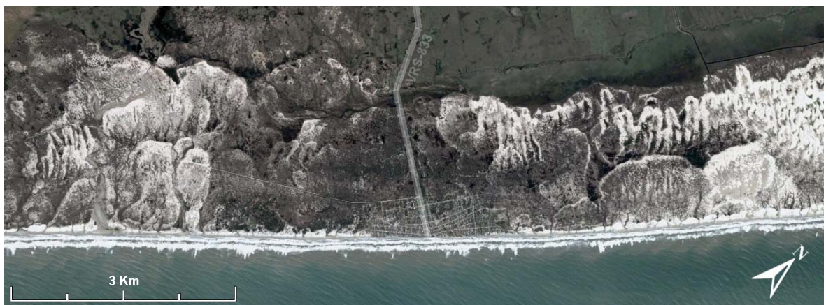
(Figura 2) Localização da Rodovia VRS-833, de acesso ao Balneário do Hermenegildo, sobre a qual foram executados perfis de GPR e sondagens SPT (Imagem Google Earth).
