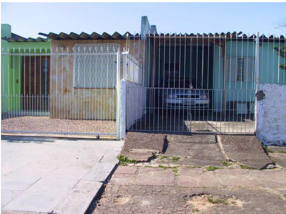
Figura 16 – Foto de unidades habitacionais existentes no Jardim Algarve. É perceptível a altura do pé direito extremamente baixa e com telhado sem inclinação.
