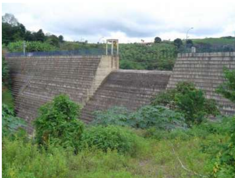
Figura 8. Barragem de Camará, no estado da Paraíba (Fonte: BARBOSA et al., 2004).
