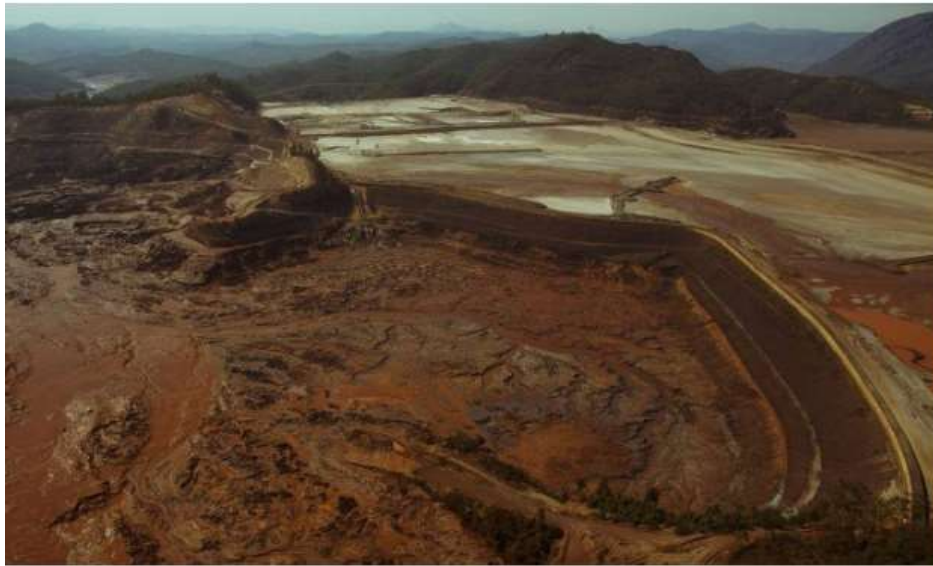
Figura 11. Barragem de Fundão, em Mariana, Minas Gerais (Fonte: GLOBO, 2016).
