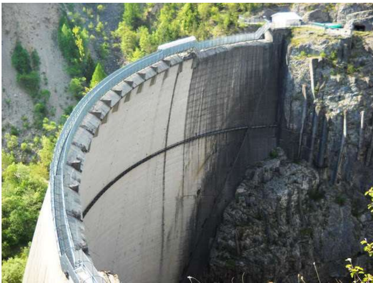
Figura 6. Barragem de Vajont, na Itália (Fonte: PRANDI, s/d).
