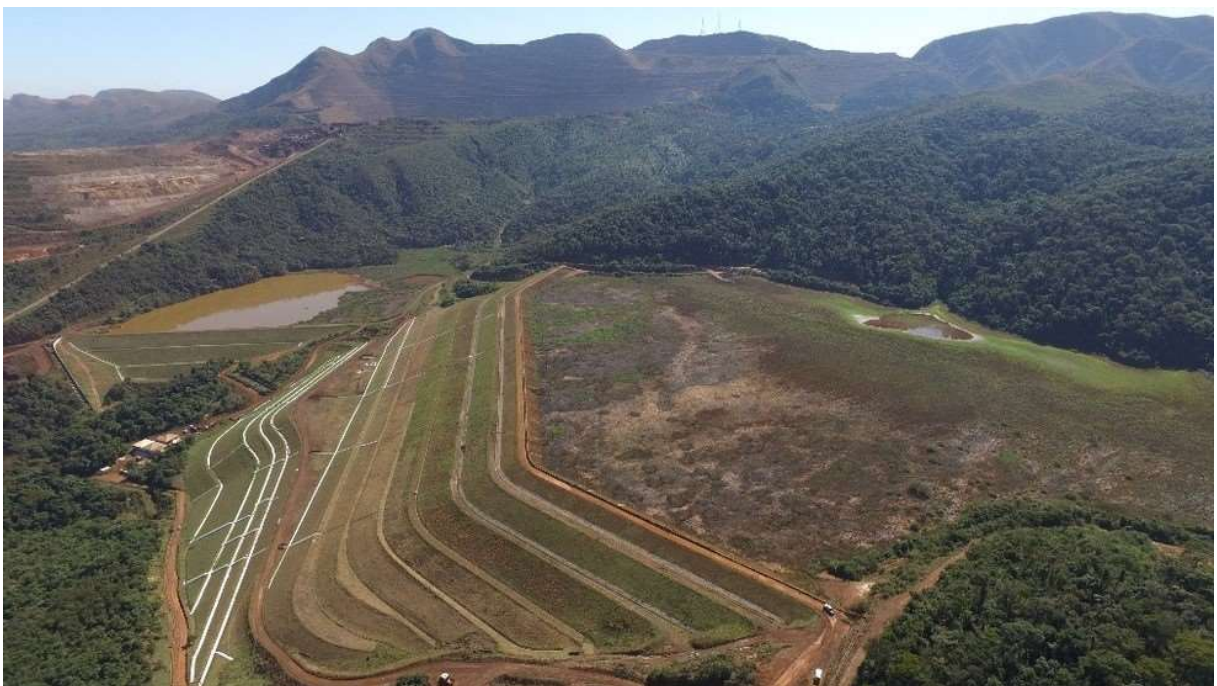
Figura 12. Barragem I da Mina Córrego do Feijão antes do rompimento (Fonte: G1, 2019).
