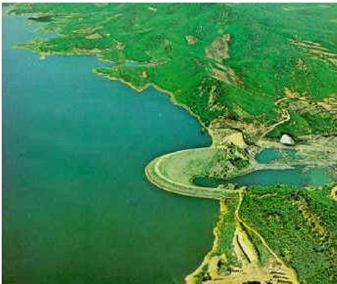
Figura 5. Barragem Orós, no Ceará (Fonte: DNOCS, s/d).
