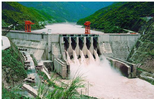
Figura 1 - Barragem de Dachaoshan na China vertedouro em operação. Fonte: Terrier (2016)
