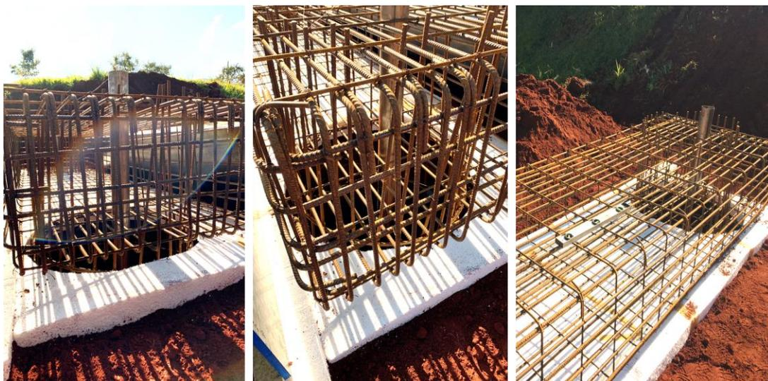
Figura 4.8: Colocação dos tubos de aço carbono e do molde EPS
