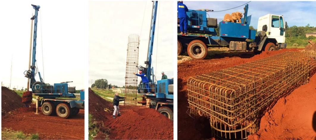
Figura 4.7: Execução das escavações das estacas com trado rotativo e colocação das armaduras
