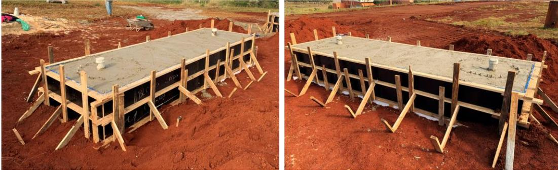
Figura 4.11: Estacas em grupo após a concretagem
