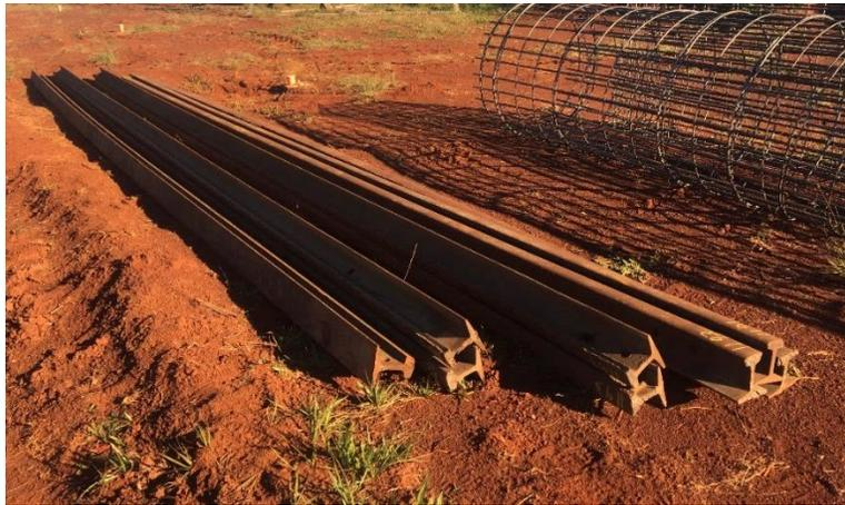
Figura 4.4: Trilhos TR 37 da armadura da estaca de reação
