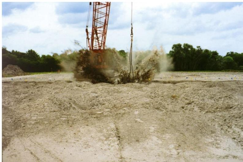
Figura 2.24: Execução de compactação dinâmica (HAYWARD BAKER, 2019,2)
