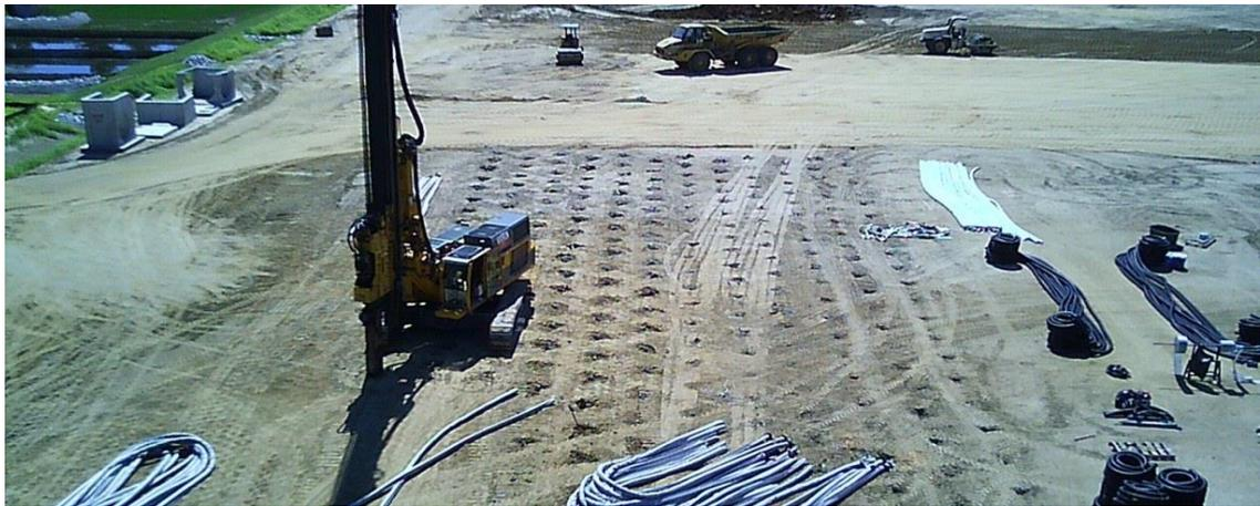
Figura 2.23: Execução de drenos verticais (HAYWARD BAKER, 2019,1)
