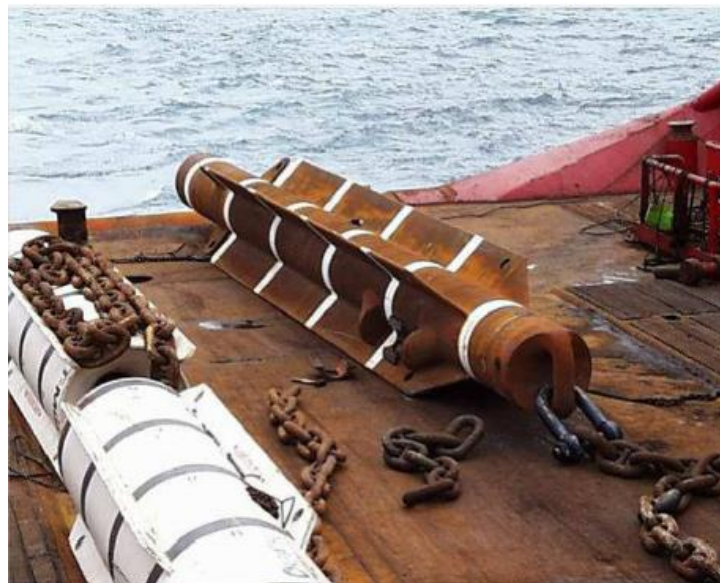
Figura 2.22: Estaca torpedo pronta para lançamento (ROCHA, M. M. et al 2016).
