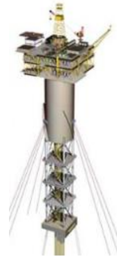
Figura 2.4: SPAR treliçado. (VILLELA, M. J. R., 2004).
