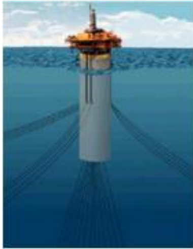
Figura 2.3: SPAR convencional. (SAMPA, N. C., 2015).
