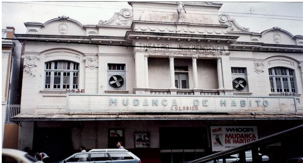
Figura 6 - Fachada do Cine Theatro Independência em março de 1994
