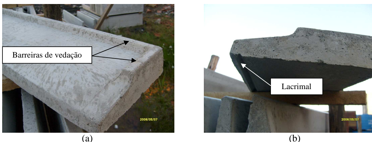
Figura 56: (a) Peitoril em concreto com a presença de barreira de vedação na interface janela/peitoril, extremidade do peitoril/alvenaria; (b) Presença de lacrimal na face inferior e declividade incorporada ao peitoril.
