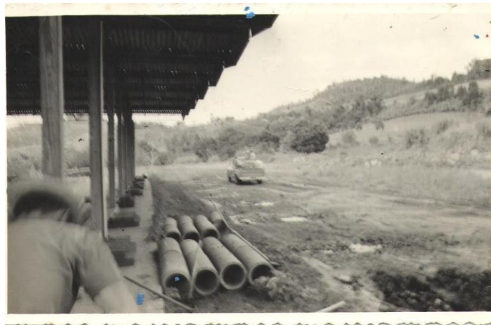
Figura 3: Registro fotográfico 1 da construção do prédio onde localiza-se a escola da comunidade atualmente. Fonte: Arquivo pessoal
