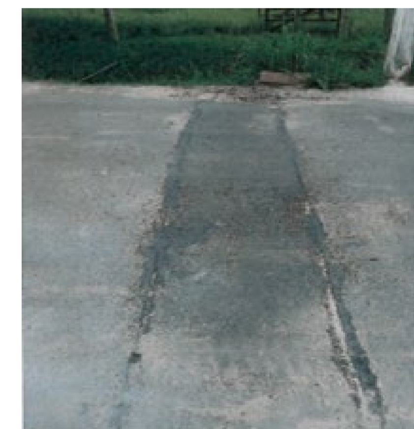
Recomposição do asfalto
