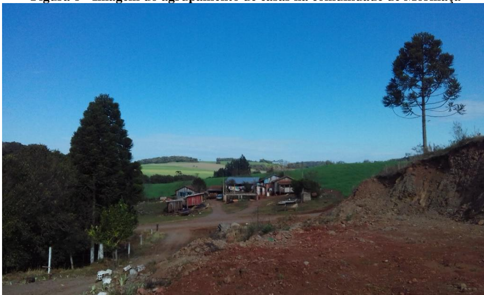
Figura 8 - Imagem do agrupamento de casas na comunidade de Mormaça
