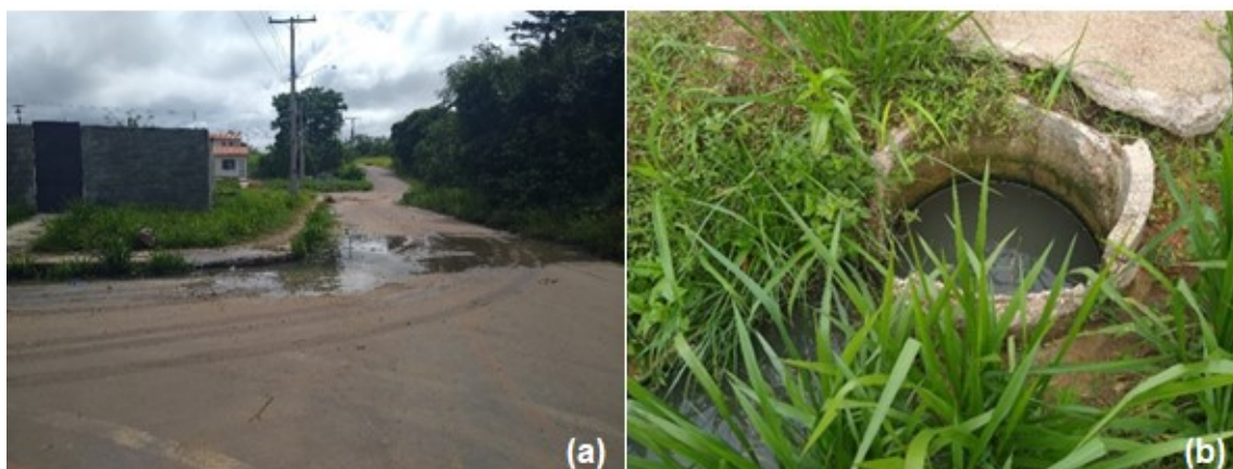
Figura 22 – Rede de esgoto entupida em frente a ETE e (b) retorno de esgoto devido ao entupimento da rede de esgotamento sanitário no bairro Poranga do município de Itacoatiara-AM
