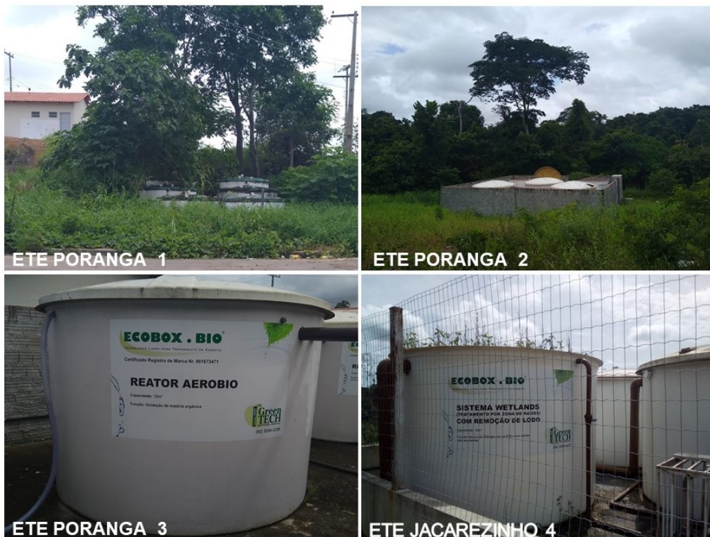
Figura 7 – ETE's compactas do município de Itacoatiara-AM
