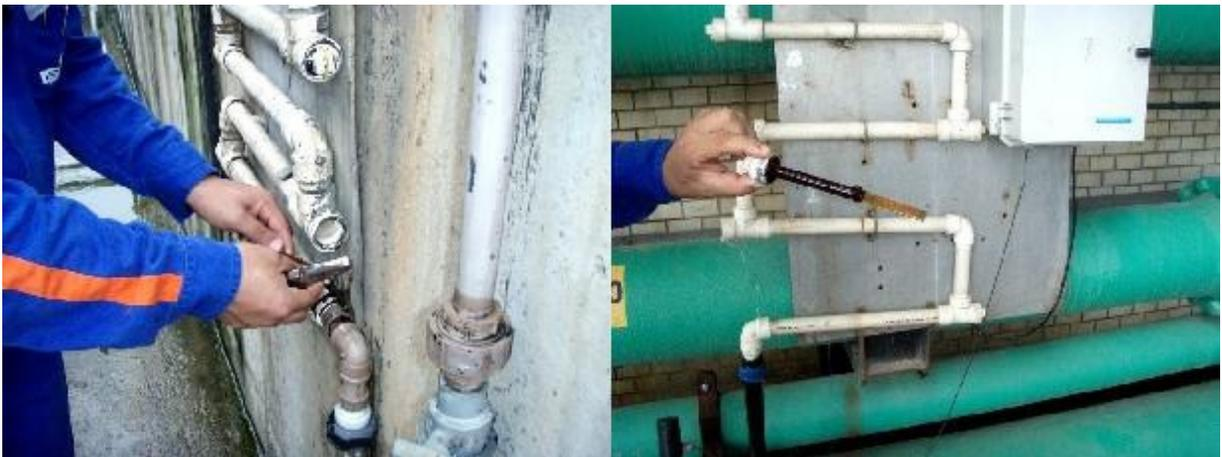
**Figura 3.5 – Exemplos de árvores de monitoração de corrosão instaladas nas saídas das Torres de Resfriamento I e II.**
