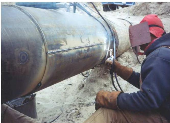
Figura 2.1: Soldagem em operação de uma dupla-calha.
