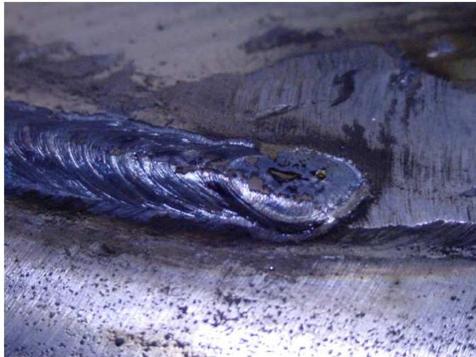
Figura 2.13: Soldagem do segundo passe de perímetro [1].
