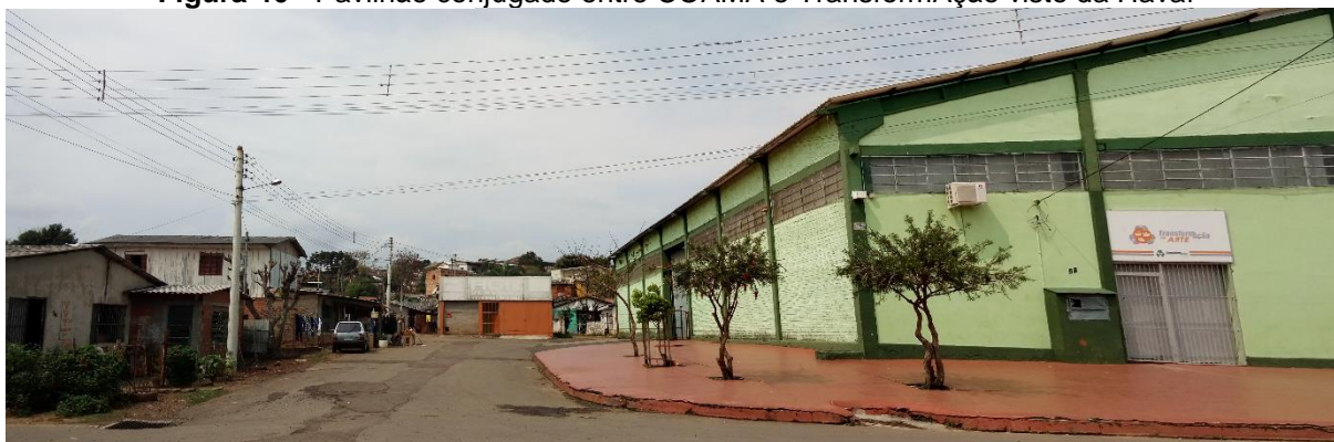
Figura 46 - Pavilhão conjugado entre COAMA e TransformAção visto da Havaí
