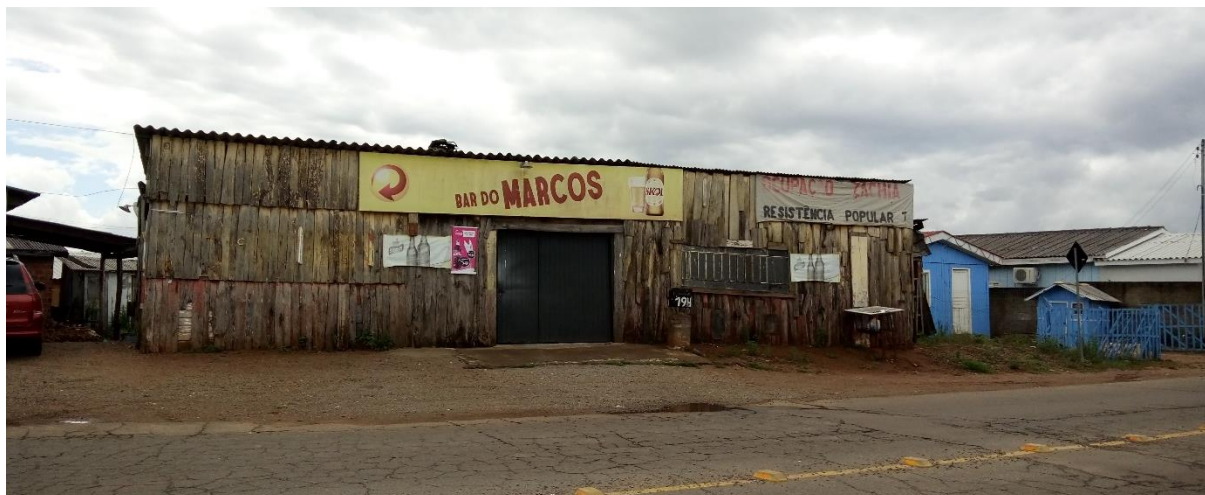
Figura 32 – Edificação que abrigou o Comitê da Ocupação 1.
