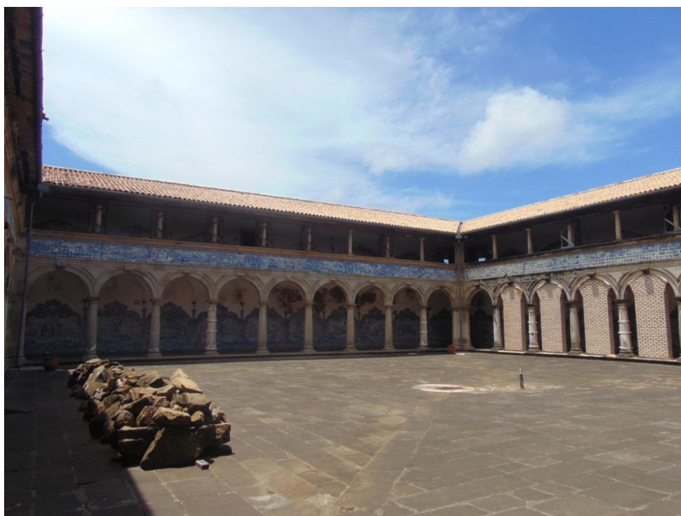
Figura 24 - Claustro da Igreja de São Francisco de Assis
