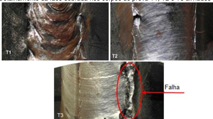
Figura 85 – Detalhamento da face dobrada nos corpos de prova T1, T2 e T3 aliviados termicamente.
