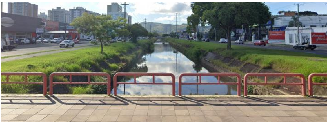
Figura 24 - Seção típica do Arroio Dilúvio entre as Av. Antônio de Carvalho e Cristiano Fischer. FONTE: Google Street View (2019).
