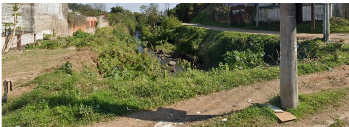
Figura 23 - Arroio Dilúvio a montante da Av. Antônio de Carvalho. FONTE: Google Street View (2019).
