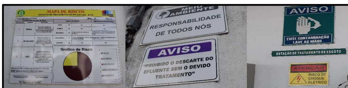
Figura 3: Mapa de riscos, placas de advertência, sinalização e recomendações das Estações de Tratamento de Esgoto (ETEs) do Hospital Dom Orione, Araguaína – TO, 2018
