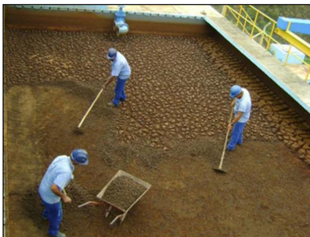
Figura 2: Limpeza de resíduos de lama de decantadores. Fonte: SAAE, 2020.
